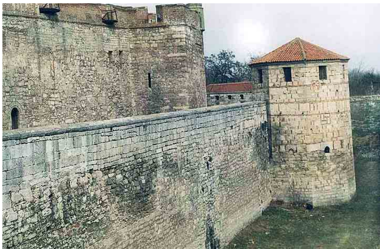
Източната стена, изглед отвън. The East wall, an outside view.
